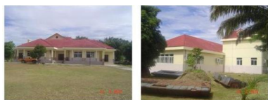
Vue de face et vue de derrière du bâtiment à usage de logement principal
