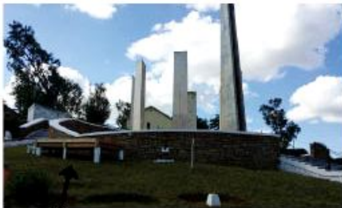
Plateforme dédiée aux JRI, sur la gauche du mausolée : vue sur les stèles et le cérémonial de dépôt de gerbe.
