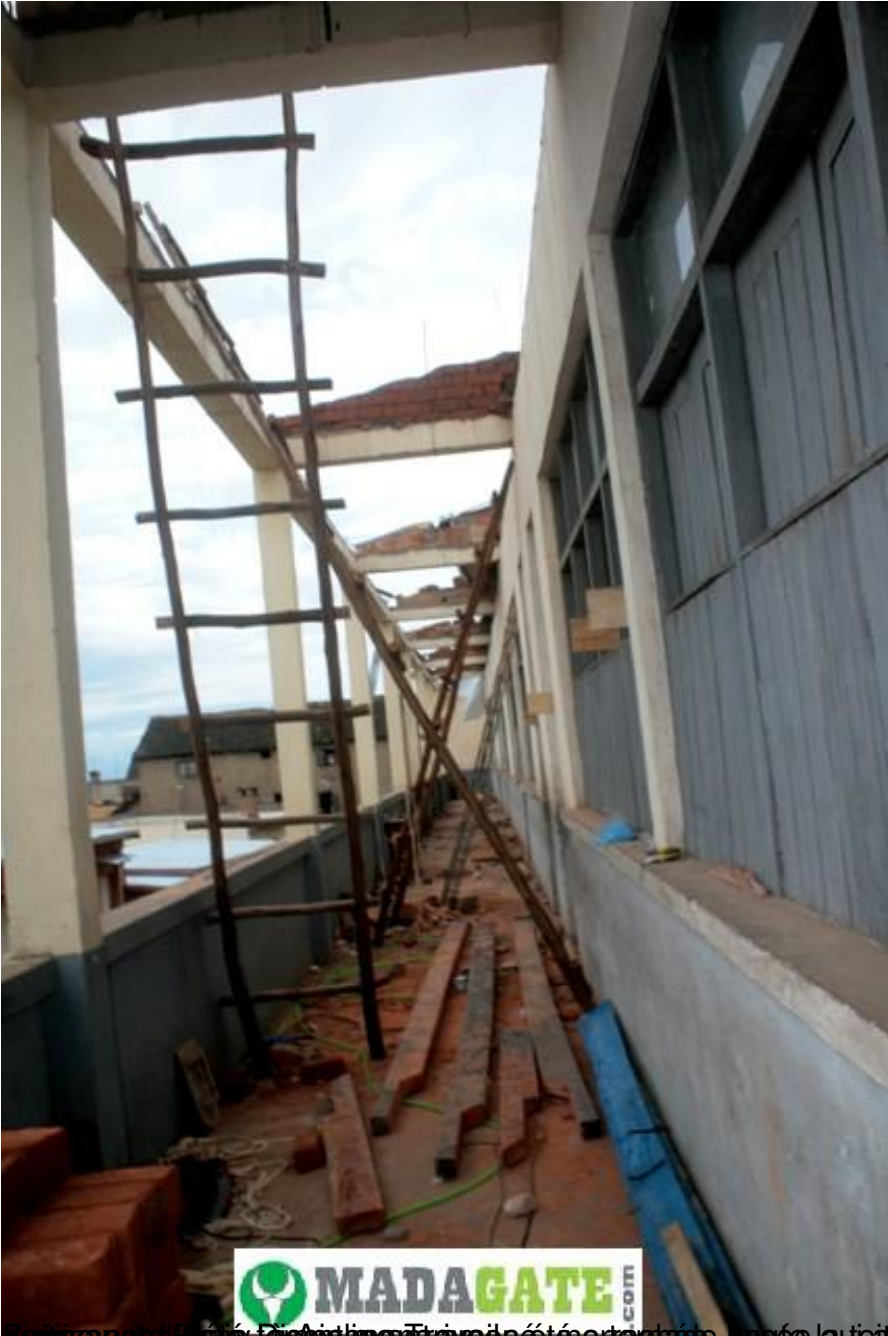
Construction de la clôture du lycée Saint Louis Fikirizana Isotry, Antananarivo. Le lycée a été construit en 1991 et dont la
